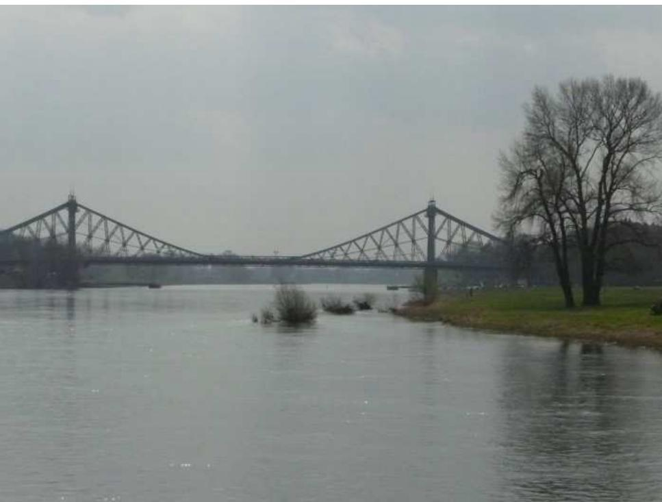
...und schließlich erreicht man die **Loschwitzer Brücke**, 1891, nur zwei Jahre nach dem Bau des Pariser Eiffelturm, wurde der Bau begonnen. Eine Meisterleistung der Ingenieurbaukunst. 100.000 Niete halten 3.500 Tonnen Stahl zusammen.
