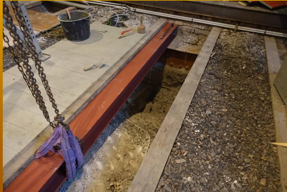
Einbau von Stahlträgern zur statischen Ertüchtigung einer Orgelempore
