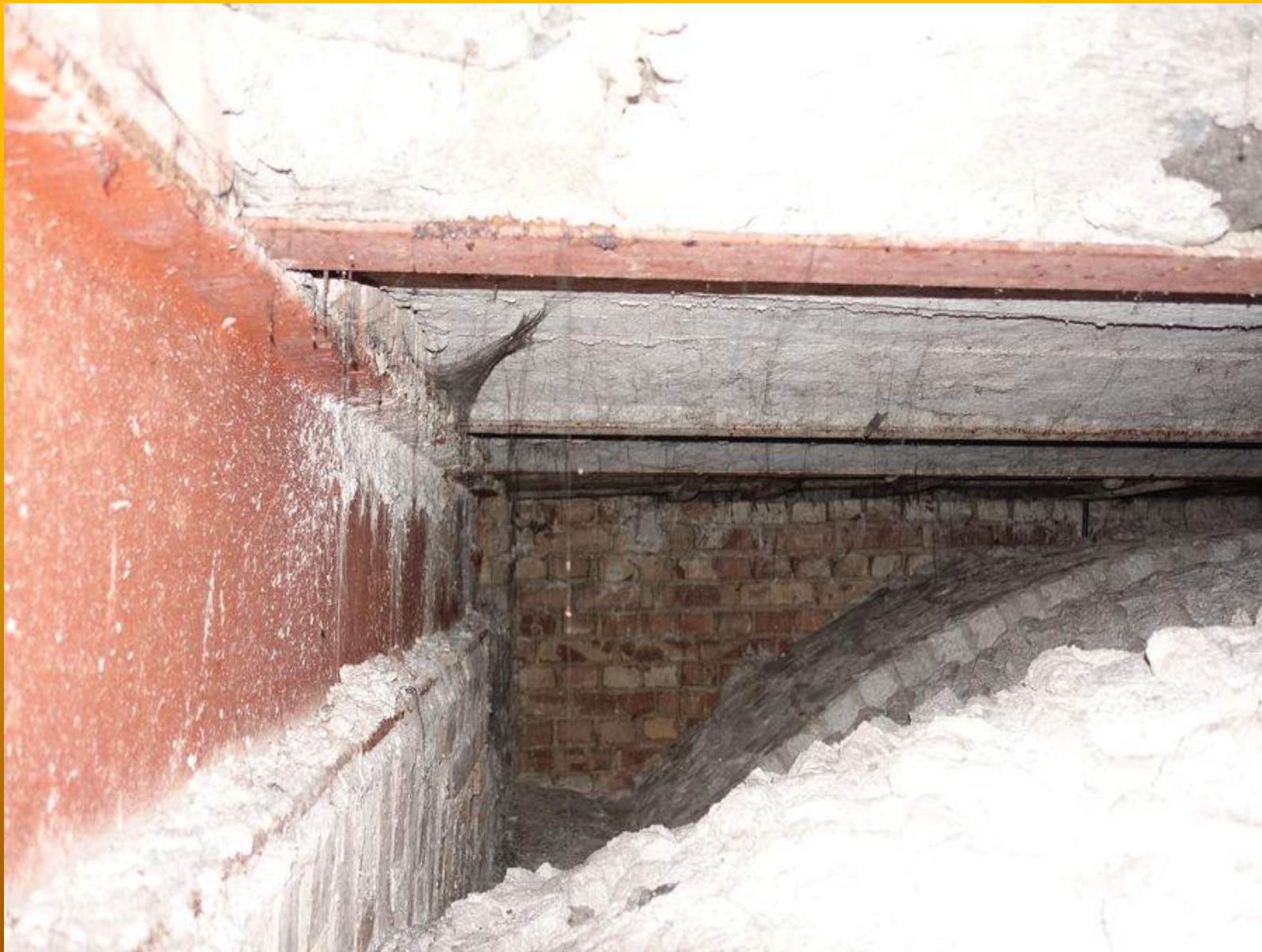
Untersuchung einer Orgelempore: Stahlträger, Auflager, Zwischenräume
