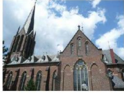
Pfarrkirche St. xxx Sanierung des Daches und der Heizung
