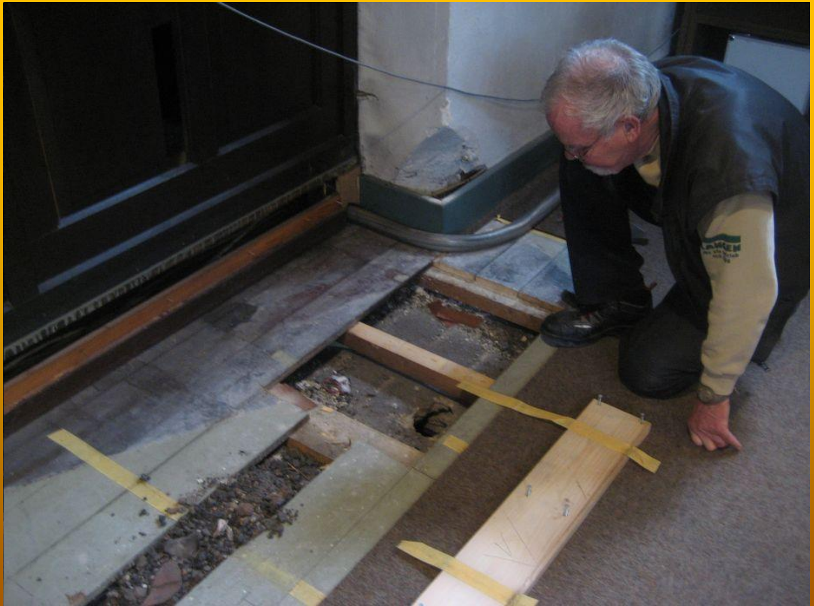
Untersuchung einer Orgelempore: Stahlträger, Auflager, Zwischenräume
