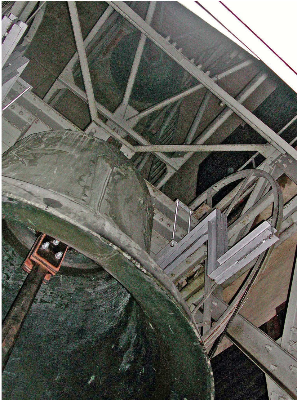
Christus-Salvator-Glocke und (ganz oben) Lobdeburg-Glocke im Südwestturm des Würzburger Domes (Zustand 2001 und vor Einbau des Zimbelgeläutes). Man achte auf die Kröpfung der Salvatorglocke in Kronenhöhe, erfolgt zur Verkleinerung des Schwungraums.
