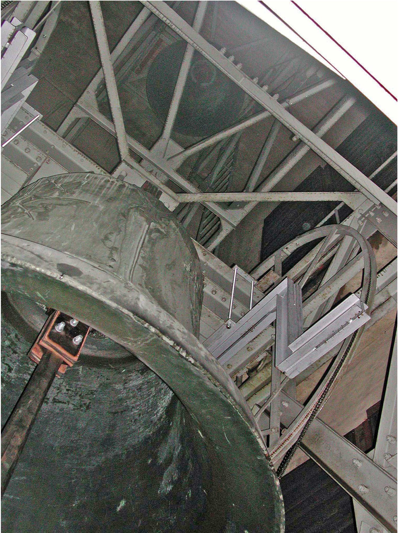
Christus-Salvator-Glocke und (ganz oben) Lobdeburg-Glocke im Südwestturm des Würzburger Domes (Zustand 2001 und vor Einbau des Zimbelgeläutes). Man achte auf die Kröpfung der Salvatorglocke in Kronenhöhe, erfolgt zur Verkleinerung des Schwungrums.
