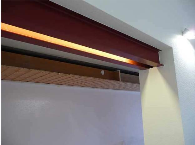
**Akzente:** Zwischen Altbau und Anbau sind an einem Durchgang Stahlträger zur Abfangung des Mauerwerks notwendig. Wenn man sie auf Lücke legt, bieten sie Platz für eine lineare Akzentbeleuchtung. Die Leuchte ist eine handelsübliche, preiswerte Langfeldleuchte, zwischen die Trägerflansche wird eine weiße Plexiglasscheibe gelegt.
